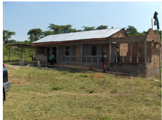
Unser Gästehaus entsteht
