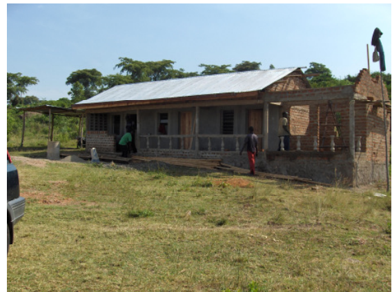
Unser Gästehaus entsteht
