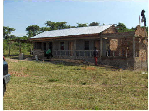
Gästehaus im Bau
